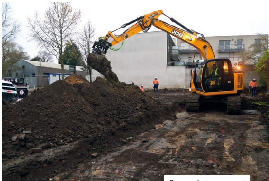
Travaux de terrassement
