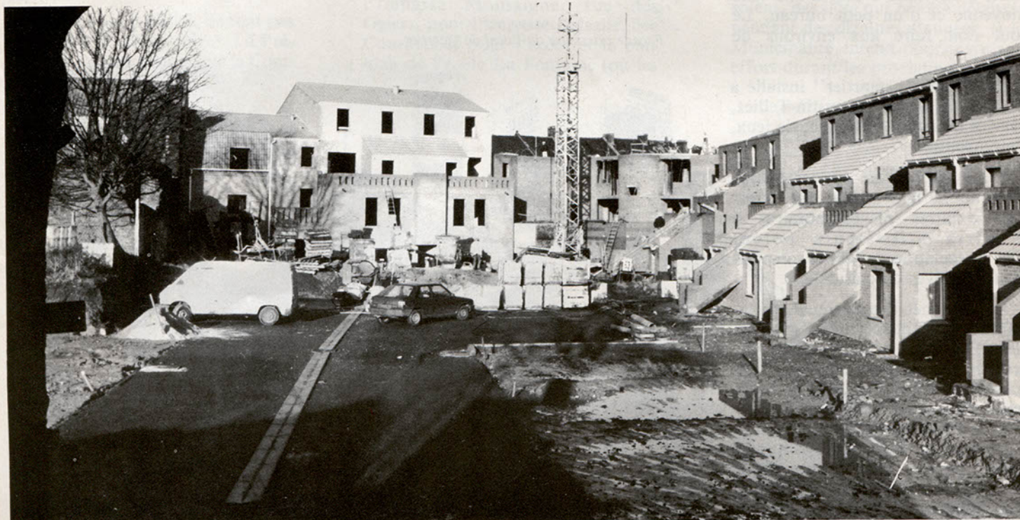
Les nouveaux immeubles sortant de terre.
