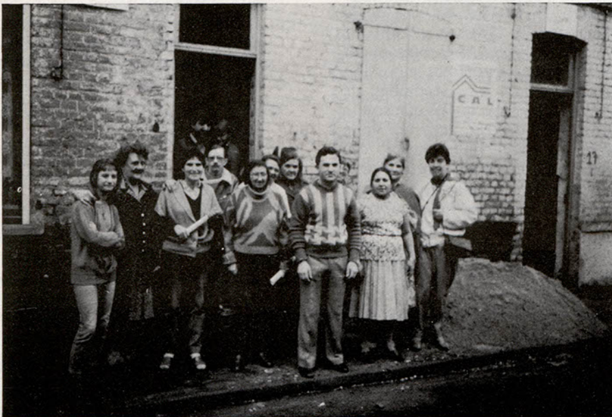
Les habitants de la rue St-Jacques devant les maisons en cours de rénovation.
