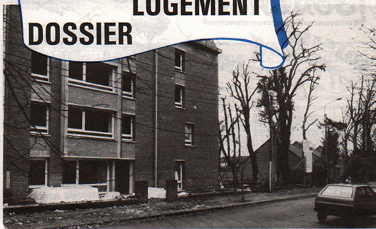
Bâtiments en construction
